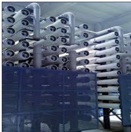
Figura 2.8. Bastidores de ósmosis inversa (Cipollina, 2009).
