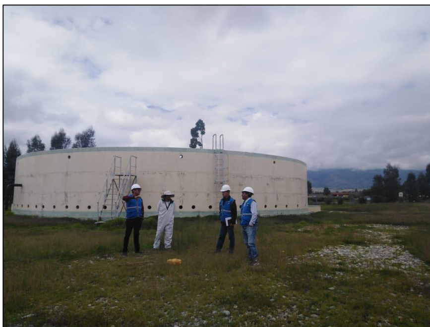
Figura 28. Planta de tratamiento de aguas residuales (Filtro percolador) de la localidad de Chupaca – Junín.
