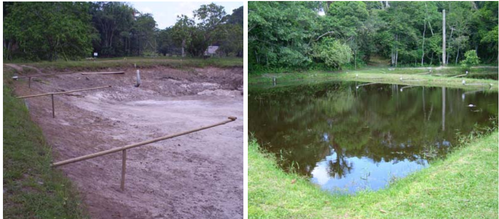
Figura 7. Estanque en preparación (izquierda) y en funcionamiento (derecha).
