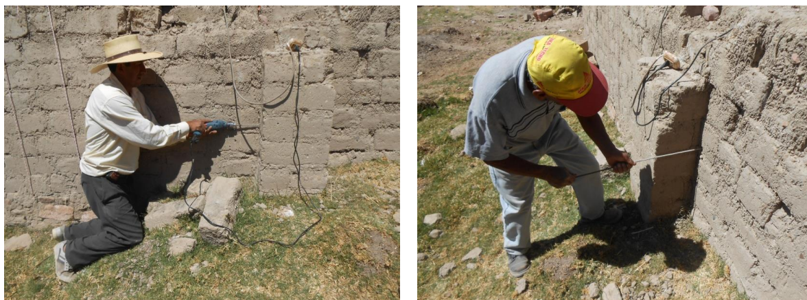
Figura 4.22. Perforación de agujeros con taladro (izquierda) y con cincel y comba (derecha).
