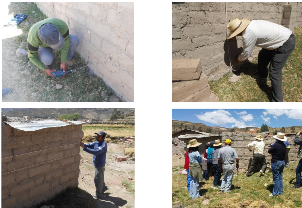
Figura 6. Sesión práctica de colocación de cuerdas horizontales y verticales en muro de cerco
