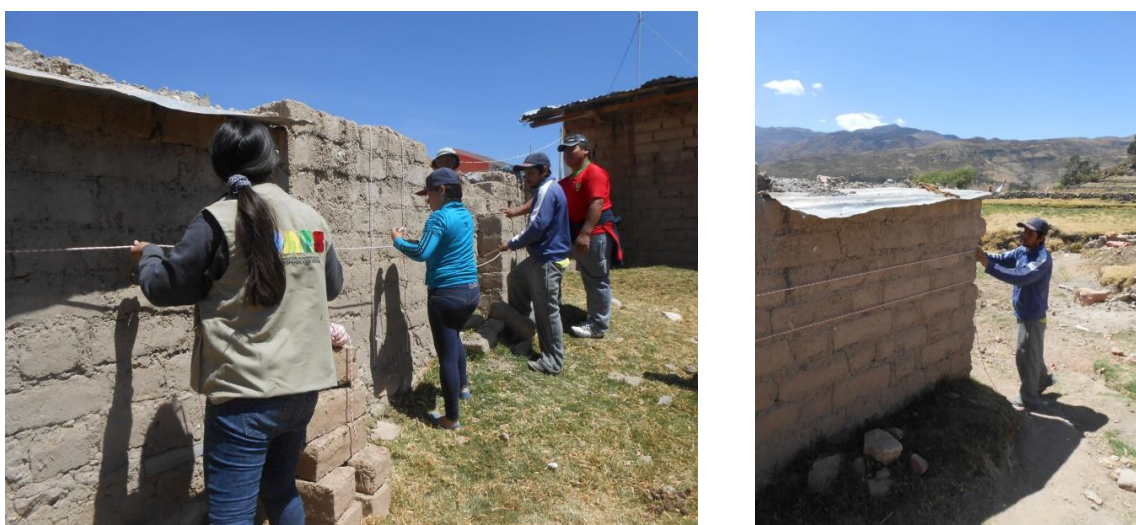
Figura 4.23. Colocación de cuerdas horizontales.
