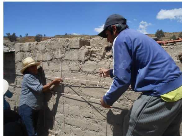
Figura 4.25. Tensado de cuerdas y amarre de nudo por parte de grupo con equidad de género y edad.
