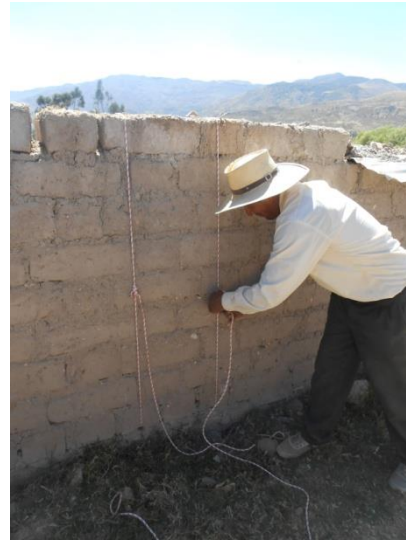
Figura 4.24. Colocación de cuerdas verticales.
