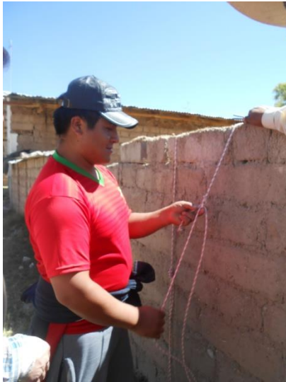
Figura 4.24. Colocación de cuerdas verticales.
