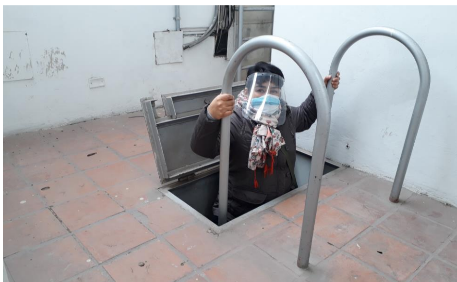
Foto 1: Escalera Vertical para acceder al Almacén (Piso 7).
