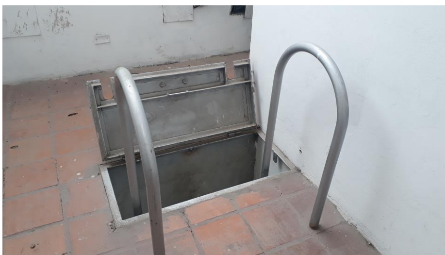
Foto 24: Escalera Vertical para acceder al Almacén (Piso 7)
