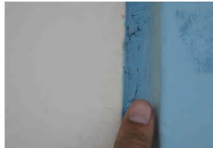
Junta de construcción en unión Tabique - Portico
