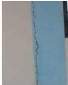
Grietas en unión tabique columna
