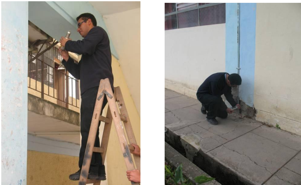
FIG. 2-13 ENSAYOS DE ESCLEROMETRÍA.
