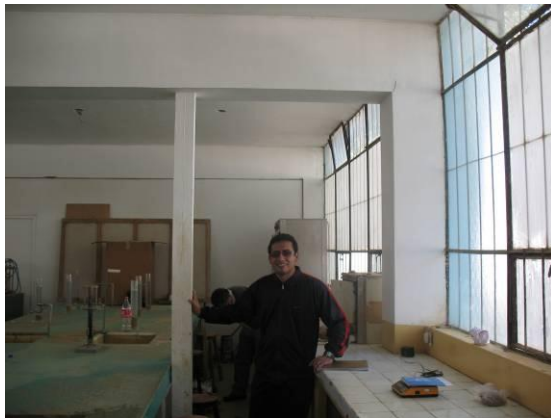
FIG. 2-11 REFORZAMIENTO DEL EDIFICIO 1B CON PILARES DE ACERO.
