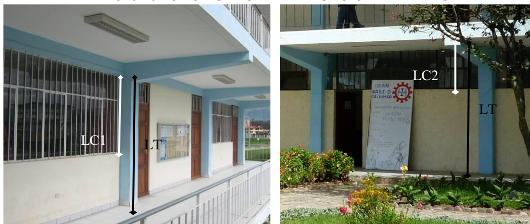
FIG. 3-15 LONGITUDES DE EVALUACIÓN DE LA RIGIDEZ.
