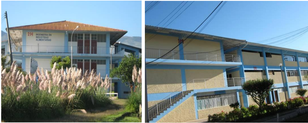
FIG. 2-2 EDIFICACIONES TÍPICAS DE LA UNIVERSIDAD NACIONAL DE CAJAMARCA
