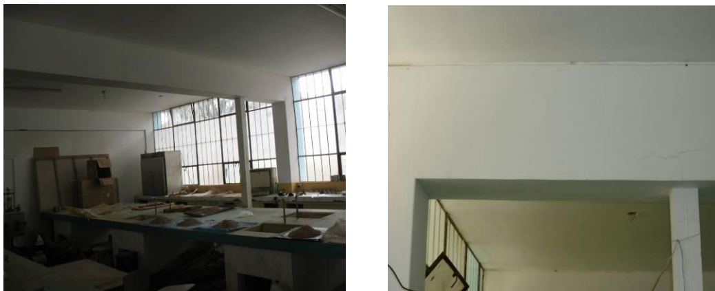
FIG. 4-2 REFORZAMIENTO DE LOS PÓRTICOS DEL PABELLÓN 1B
