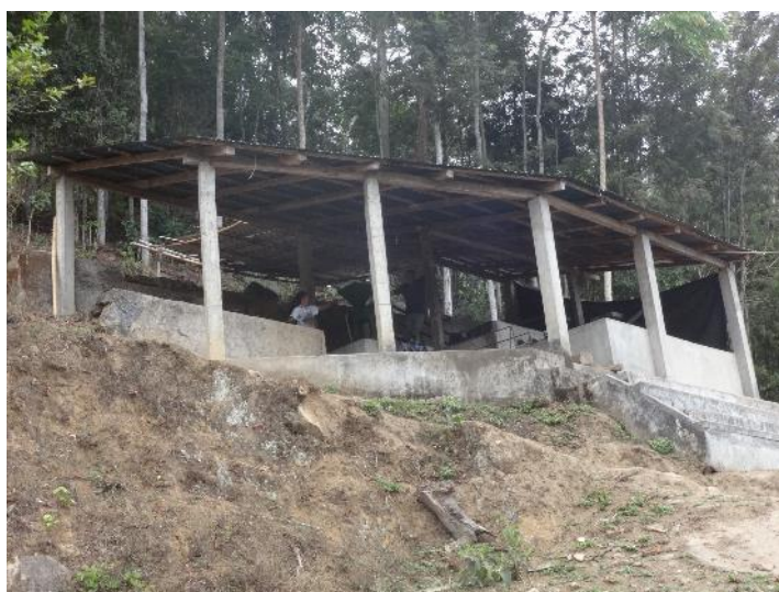
Figura 7 Vista frontal de la planta de beneficio. Fuente: R. Rodríguez, Octubre 2014
