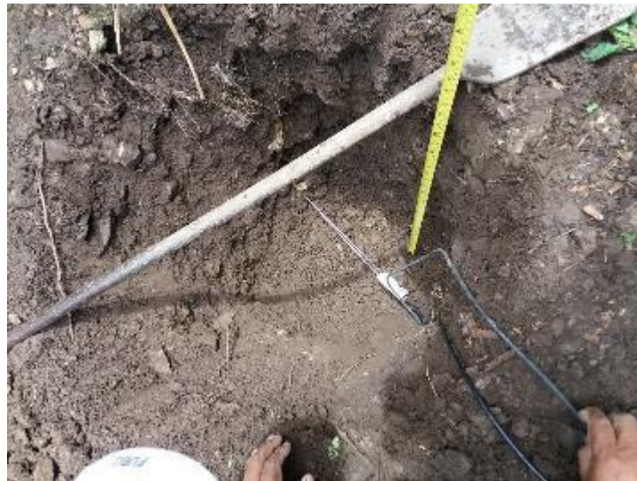
Figura 98 Instalación de los sensores de humedad y temperatura del suelo Fuente: Elaboración propia.
