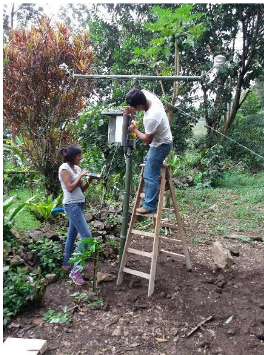
Figura 104 Sellado con silicona del datalogger Fuente: Elaboración propia.
