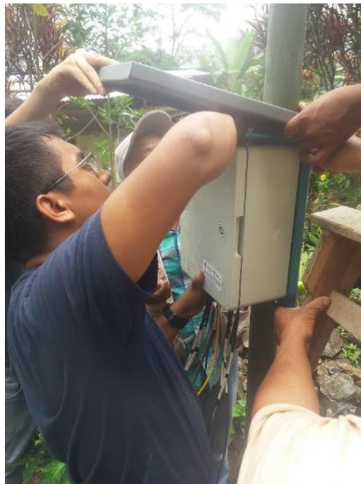
Figura 95 Instalación del techo de la caja de datalogger Fuente: Elaboración propia.
