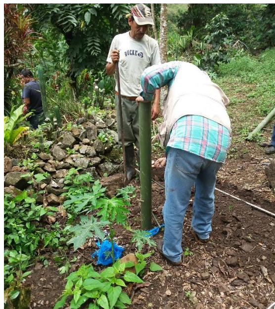
Figura 91 Instalación de la base de la estructura Fuente: Elaboración propia.
