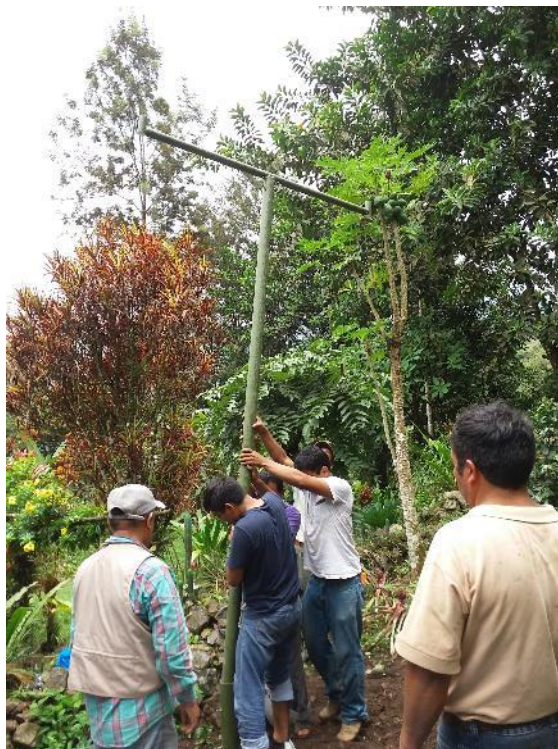
Figura 92 Instalación de la estructura principal Fuente: Elaboración propia.
