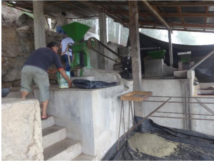
Figura 8 Maquinaria de la planta de beneficio Fuente: R. Rodríguez, Octubre 2014
