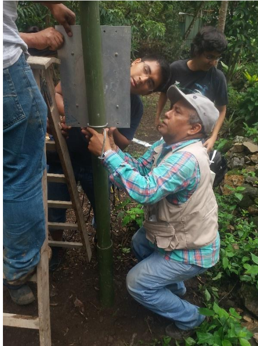
Figura 94 Instalación de la estructura principal Fuente: Elaboración propia.
