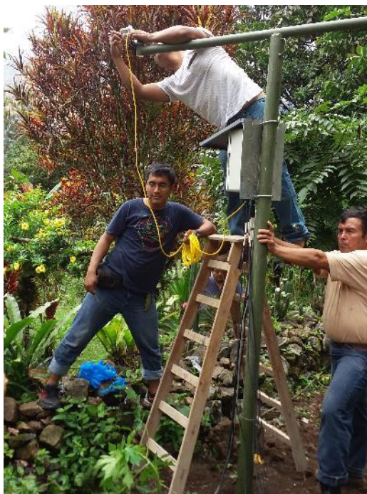
Figura 96 Instalación de los sensores de radiación Fuente: Elaboración propia.
