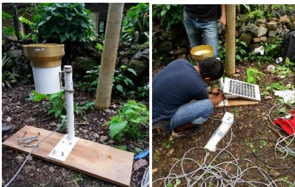
Figura 101 Instalación panel solar y pluviómetro Fuente: Elaboración propia.
