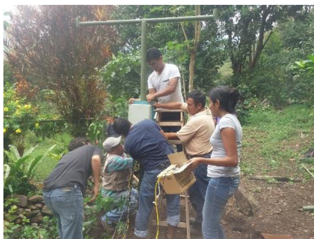
Figura 93 Instalación de la estructura principal Fuente: Elaboración propia.
