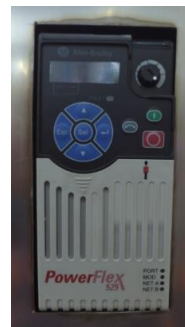
Figura 3.15. Variador de frecuencia.
