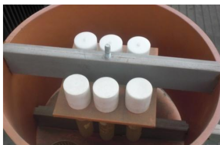
FIGURA 15. Instalación de dispositivos.
