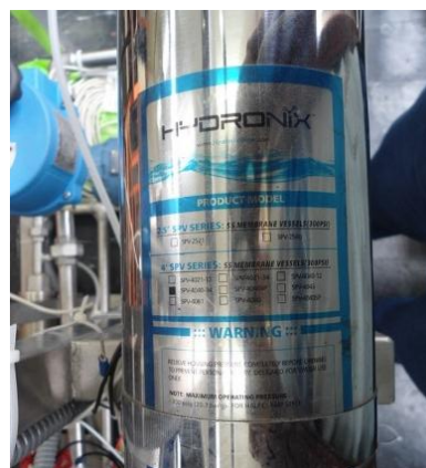
Figura 4.24. Contenedores de membranas para ósmosis inversa.
