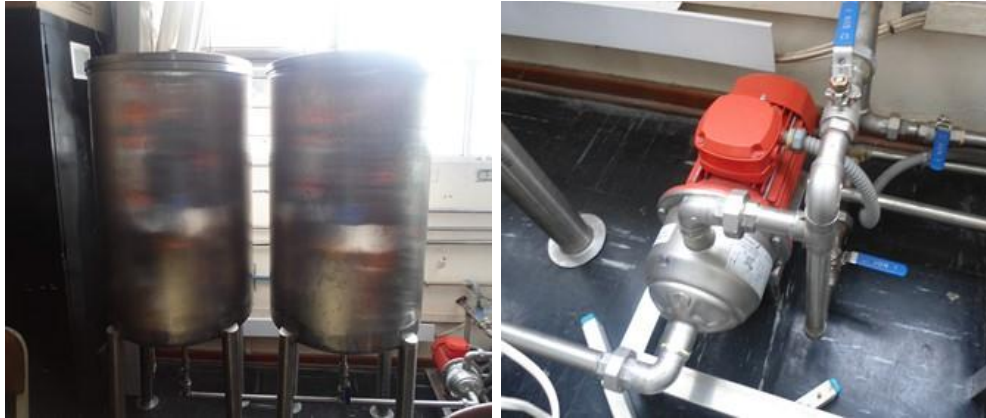
Figura 4.25. Tanques de almacenamiento y bomba de realimentación.
