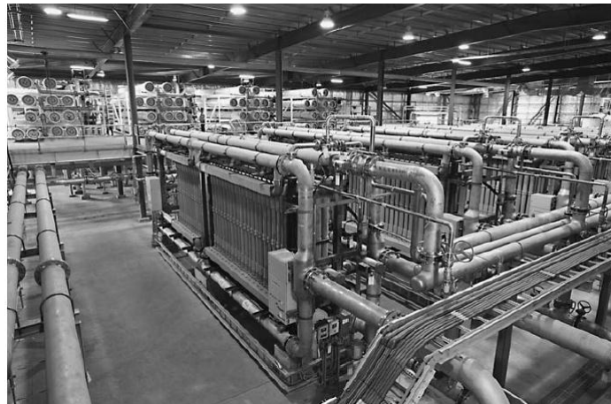
Figura 2.5. Arreglo de membranas para el pretratamiento de agua de mar [4].
