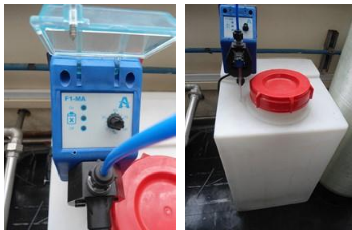
Figura 4.21. Sistema dosificador de ácido.
